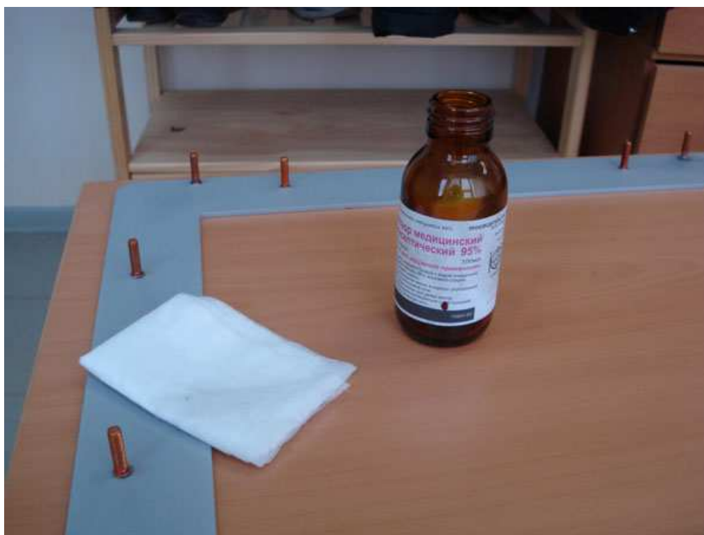
Рисунок 30: обезжириваю поверхность
