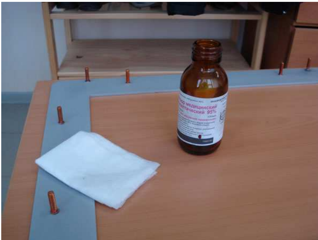
Рисунок 3: рамка ОСМП2М, обезжириваем поверхность
