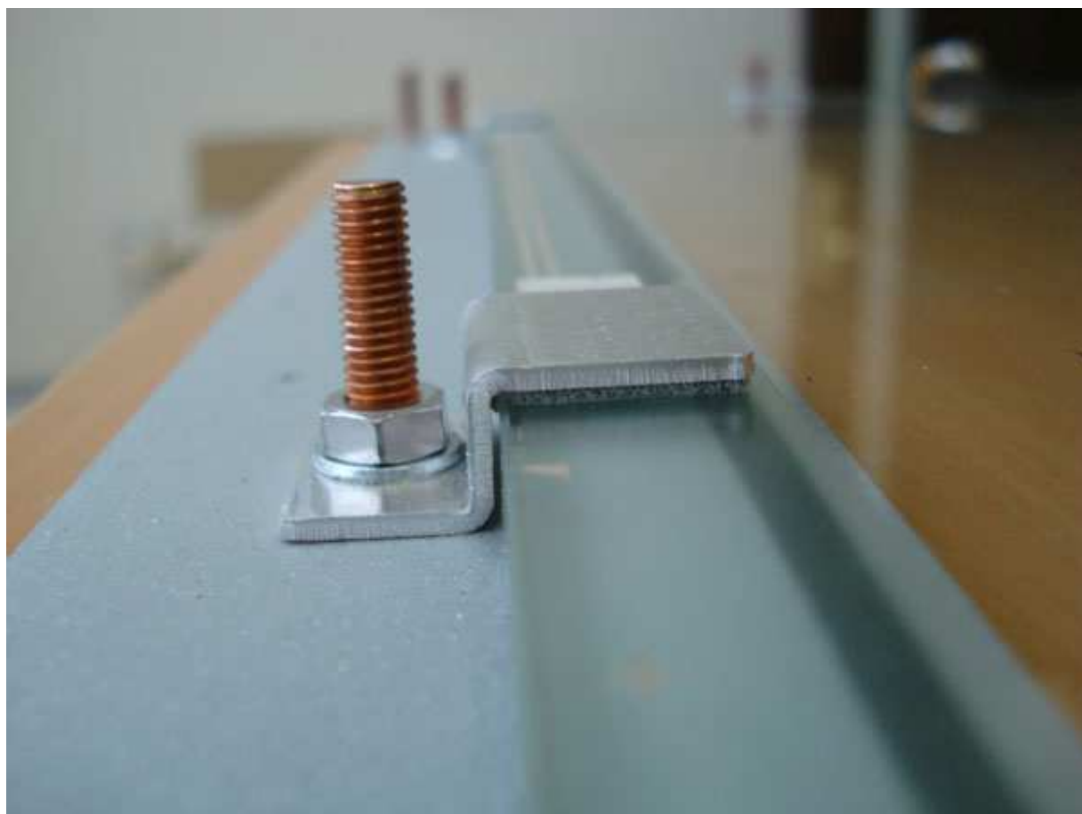
Рисунок 11: уголок НЕ ДОЛЖЕН касаться металлической частью стекла
